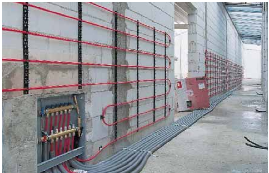
3 Рис. 10: Монтаж системы настенного отопления "мокрым" способом
