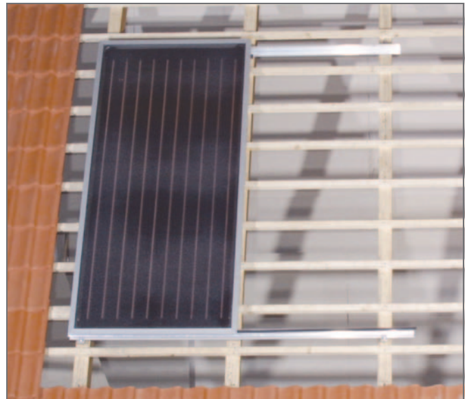
Abb. 3-9 Einbausituation Indachmontage
