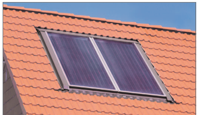
Abb. 3-10 Ansicht der fertigen Indachmontage
