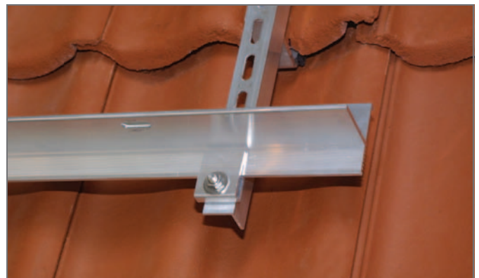
Abb. 3-6 Quer- und Längsprofil am Dachbügel montiert
