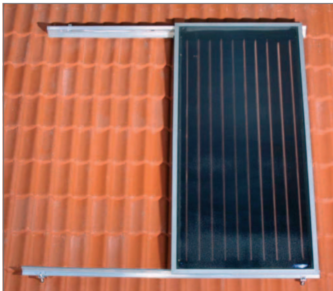
Abb. 3-8 Erster Kollektor montiert im Zweierfeld
